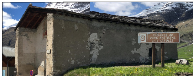
façade Est mur Gouttereau Est
