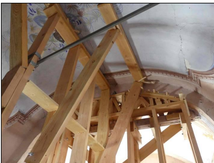
Ph11 - Chapelle St Etienne la voûte du chœur Avec étaieage de l'arc doubleau et de la nef
