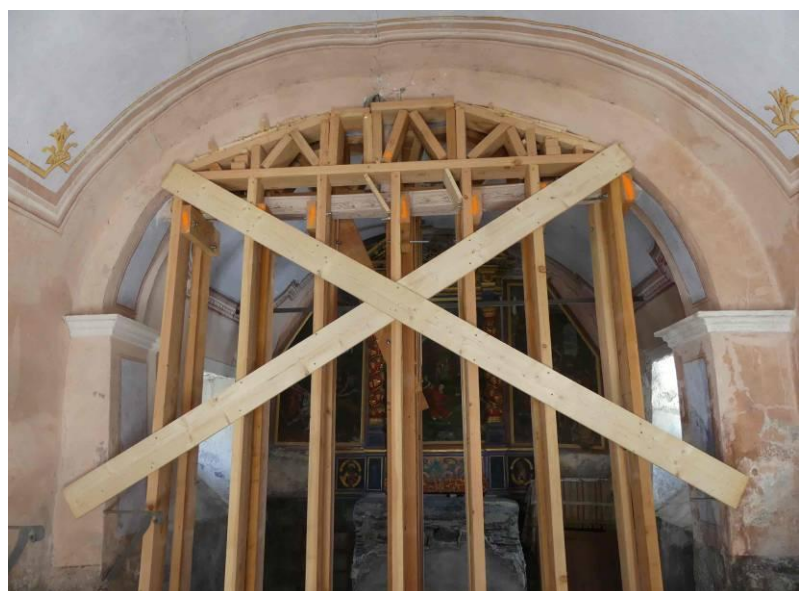
Ph7 et ph8 - Chapelle St Etienne arc doubleau mis sous étais
