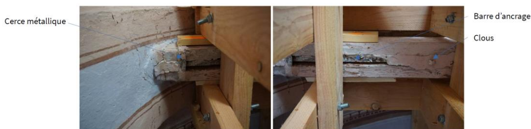
Figure 6 Barre d'ancrage métallique sous la poutre de gloire (photos côté nord)
