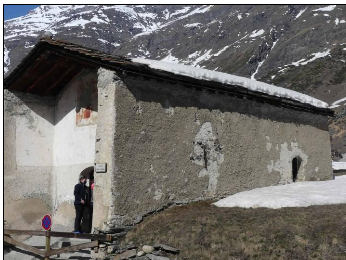
Ph3 - Chapelle St Etienne Façades Est (semi-enterrée)
