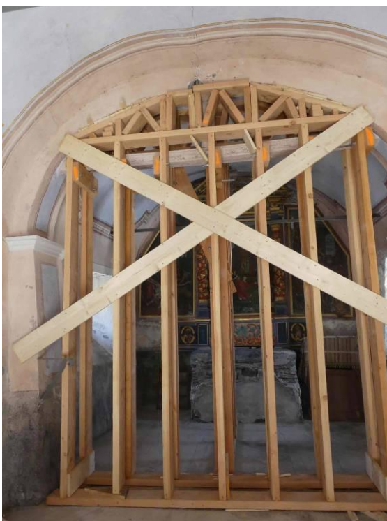
Ph7 et ph8 - Chapelle St Etienne arc doubleau mis sous étais
