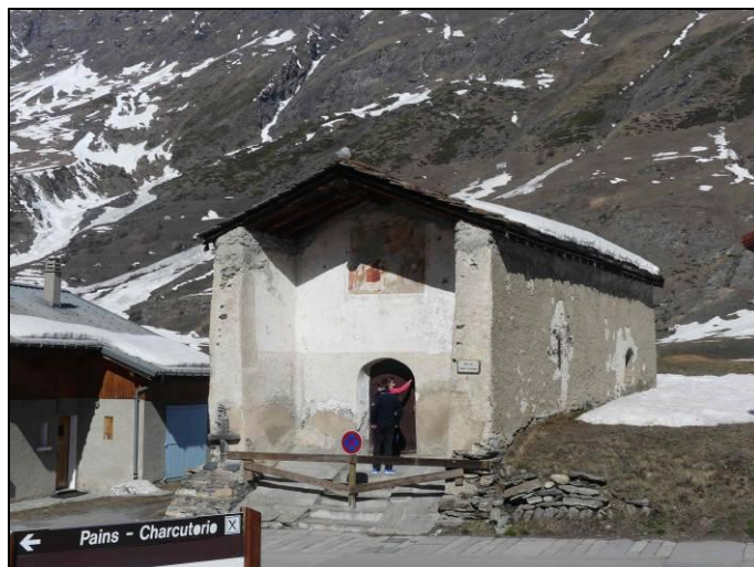
ph2 - Chapelle St Etienne Façades Sud emmarchement
